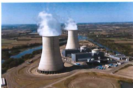
La centrale de Golfech
